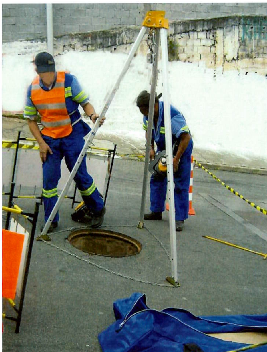
Figura 04 - Preparação e montagem do tripé
