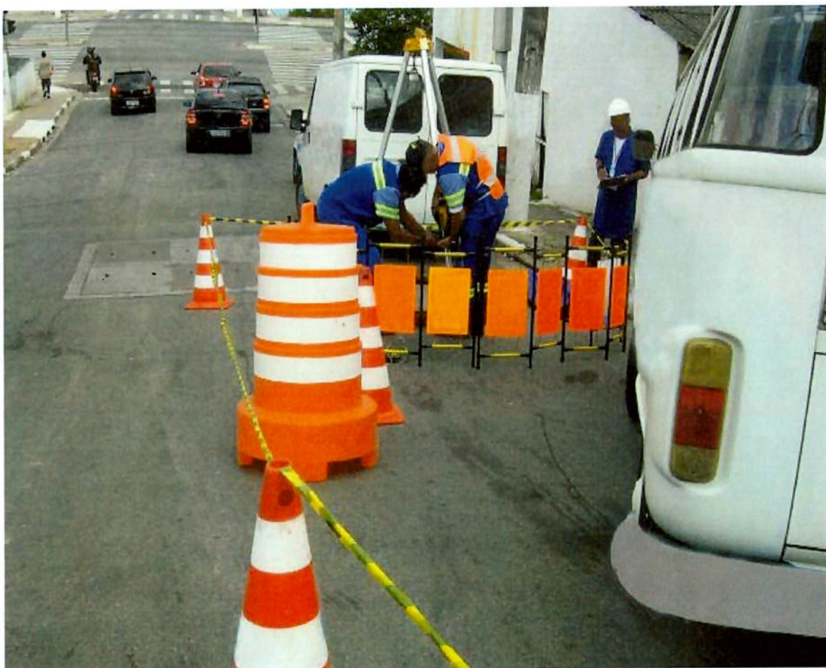
Figura 01 - Montagem do tripé e a sinalização muito próxima ao poço de visita.
