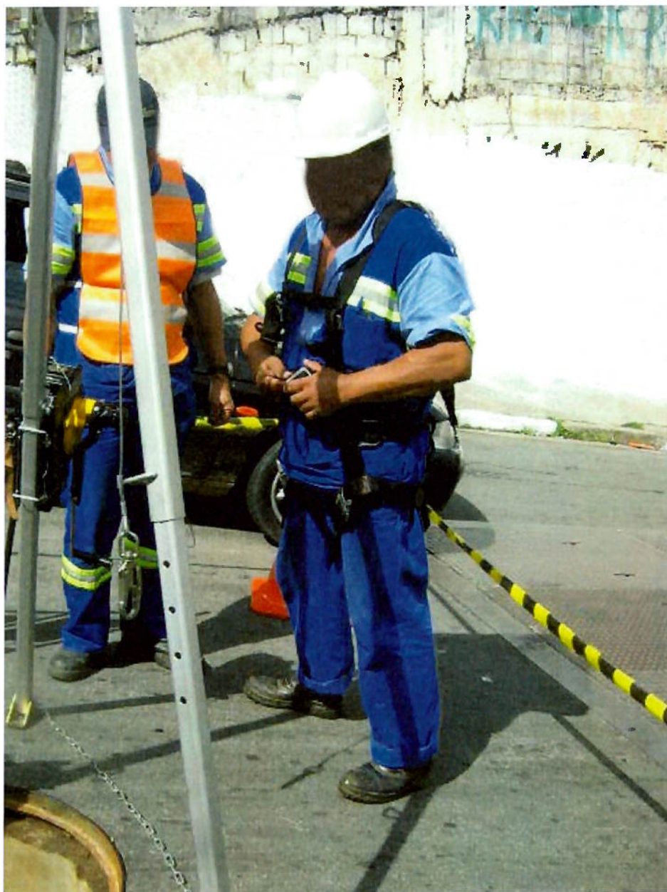
Figura 06 - Aplicação do cinto de segurança tipo pára-quedista para os locais de espaços confinados no empregado autorizado.
